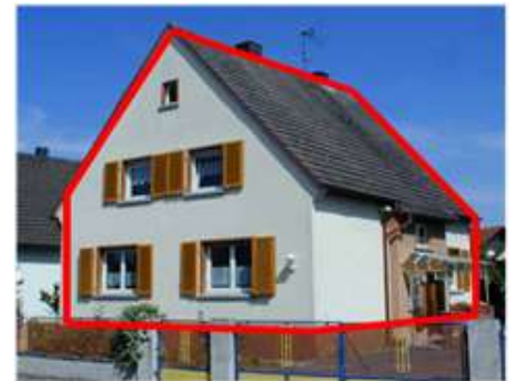
Abb. 60: Beispielhaus für umfassende Sanierung
