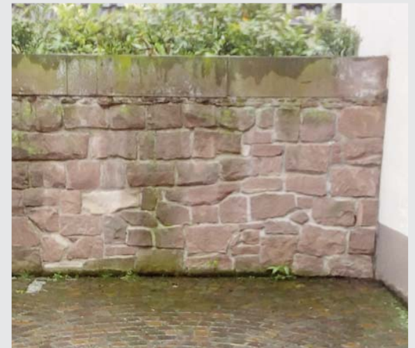
Einfriedung aus Sandstein
