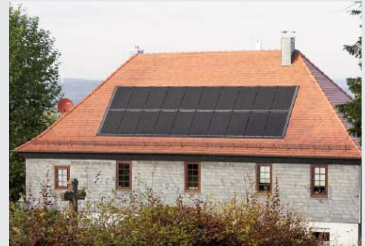
Bsp. Solaranlage auf Walmdach
