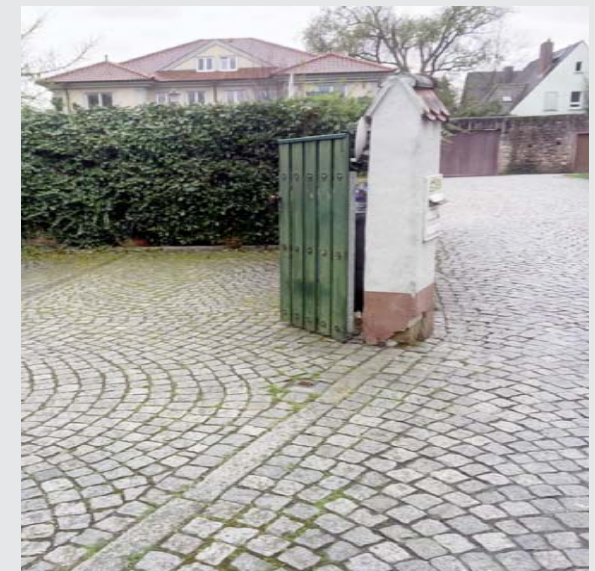
Hofpflaster passend zur Verkehrsfläche
