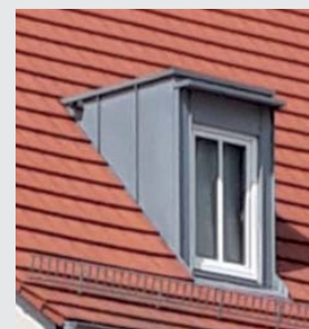
Flachdachgaube mit Zinkblech
