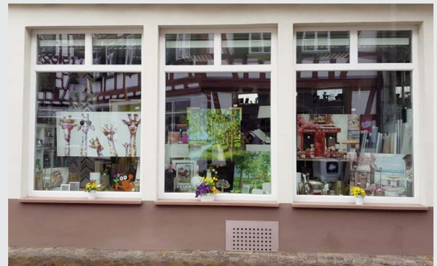
Schaufenster mit Zwischenstützen und Kämpfer
