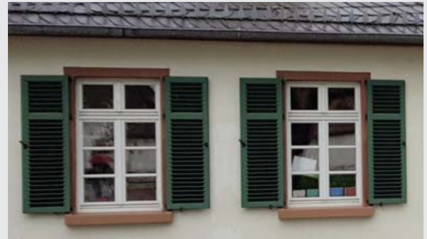
dreiflügeliges Fenster mit Sprossen
